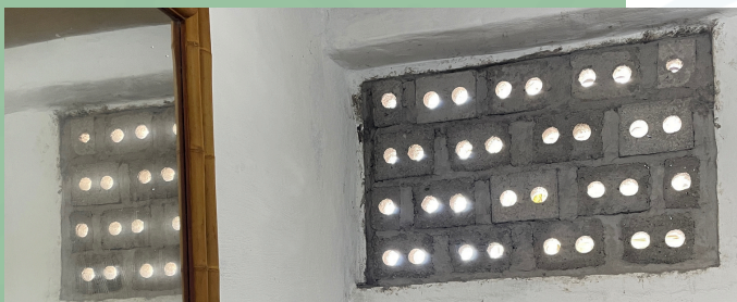
Climatización Casa Rosada
